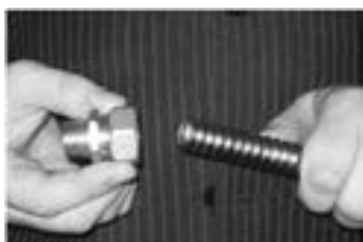
Рис 2 Вставляем в трубу фитинг до упора
